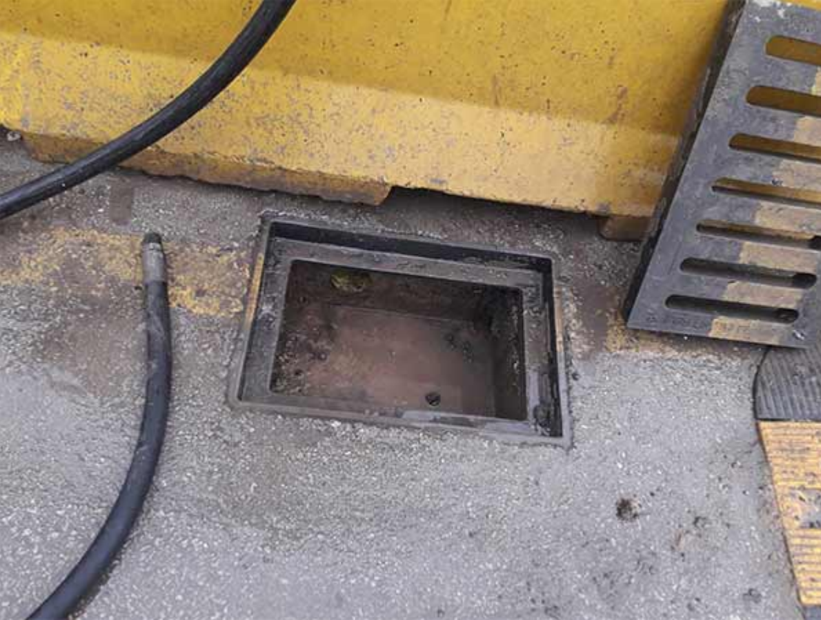
Kanal Tıkanıklığı Açma 10. Aşama
