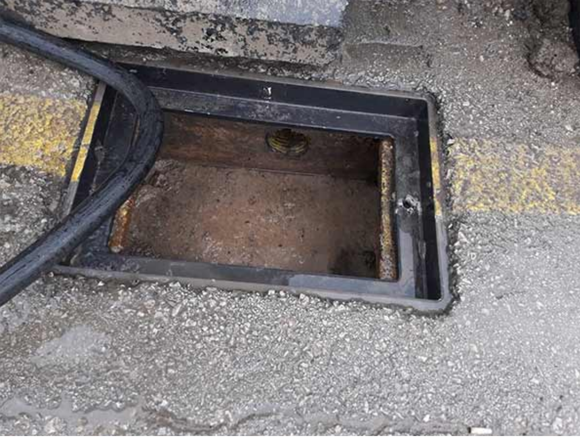
Kanal Tıkanıklığı Açma 9. Aşama
