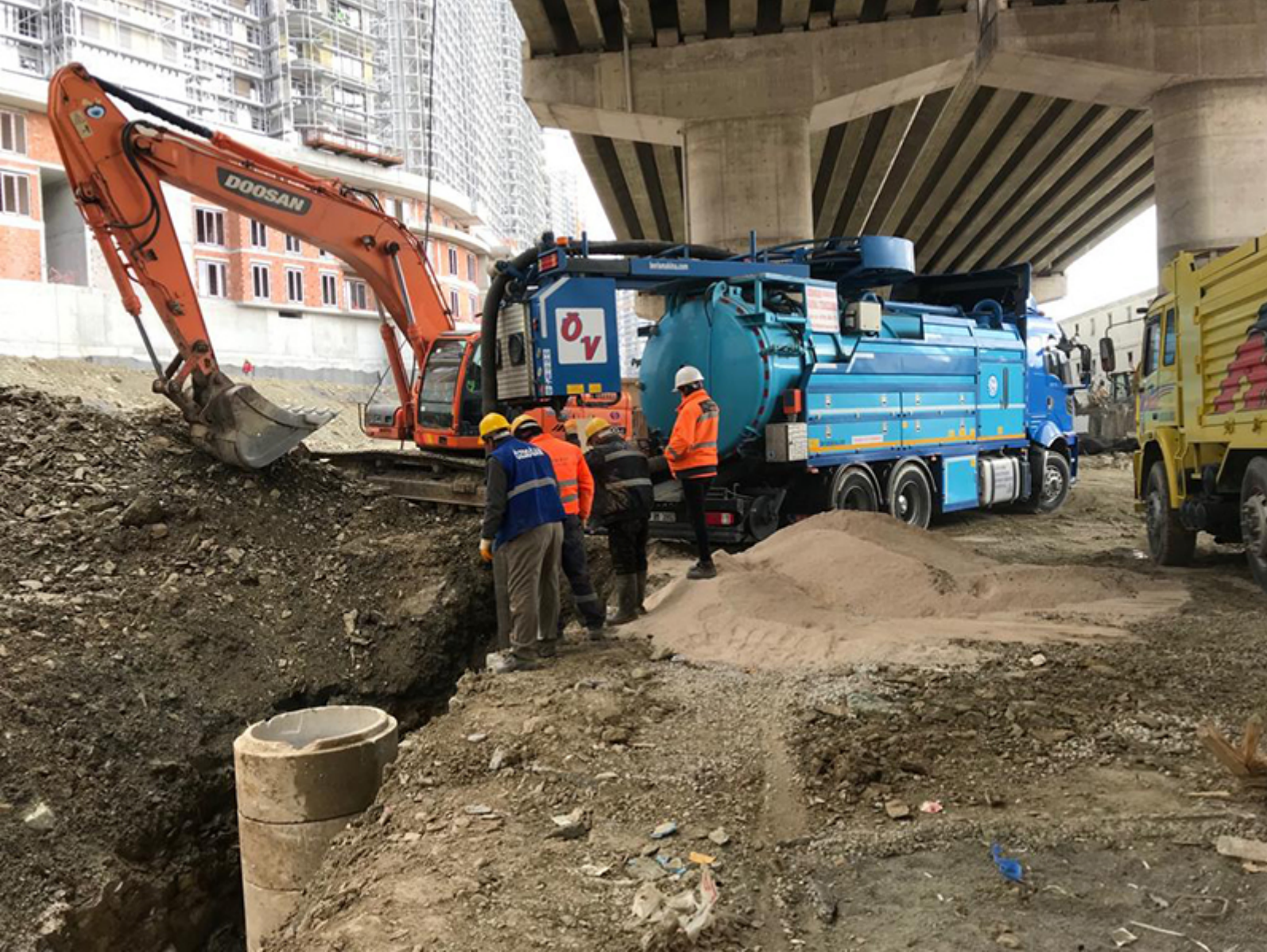
Kanalizasyon Hat Yenileme İşleri
