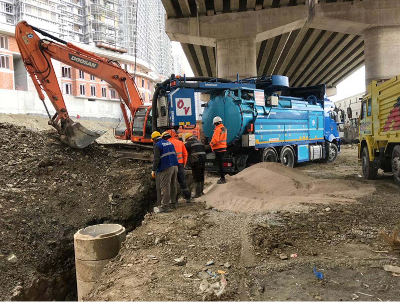
Kanalizasyon Hat Yenileme İşleri
