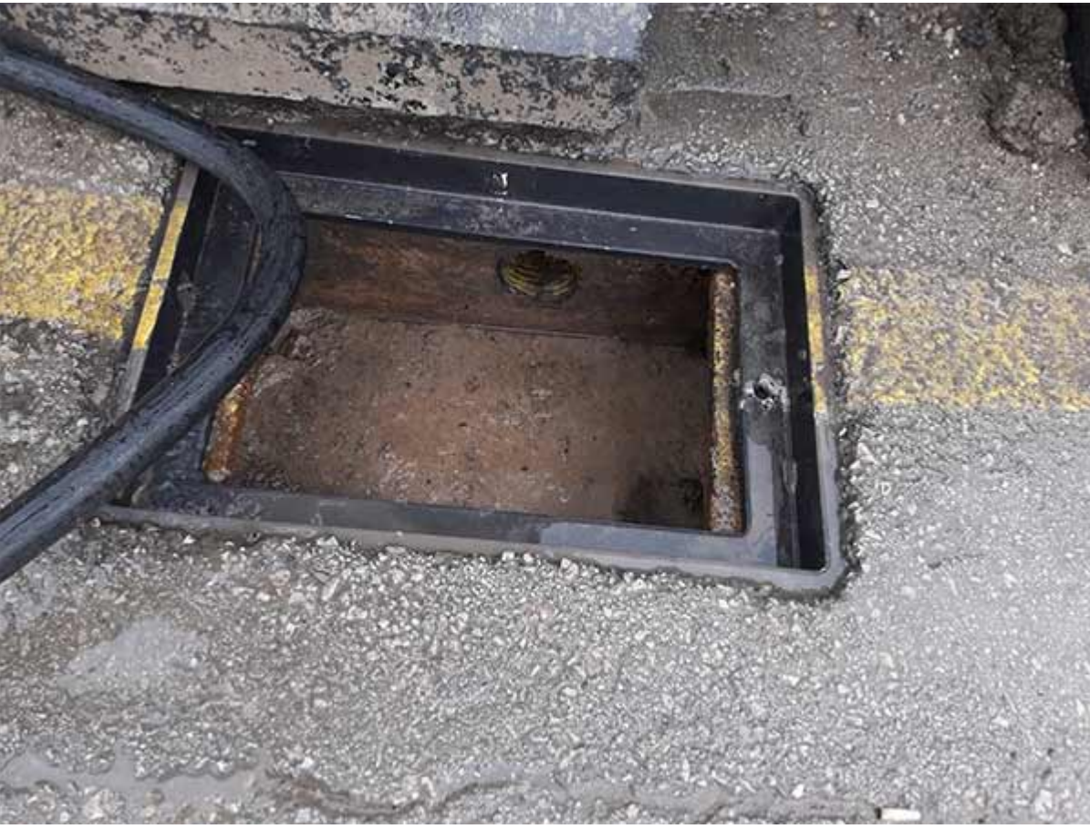
Kanal Tıkanıklığı Açma 9. Aşama
