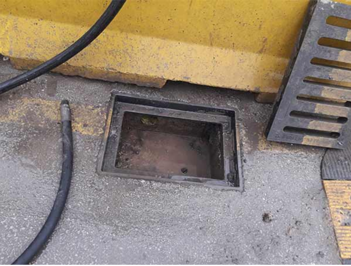
Kanal Tıkanıklığı Açma 10. Aşama
